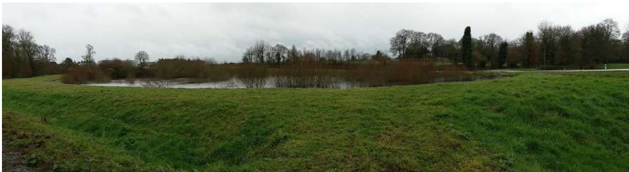
Figure 19 : Illustration du plan d'eau collectant les eaux pluviales dans le secteur Sud de la ZA du Bois Vert
