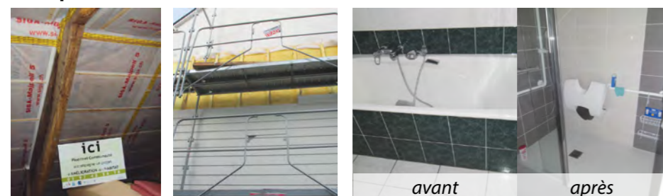
Isolation des combles
