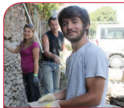
Comme chaque année, un chantier international s'est déroulé pendant l'été. L'occasion pour les jeunes de Concordia de poursuivre la rénovation des remparts de la ville.
