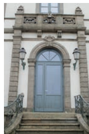
L'ancienne entrée principale avant la touche finale du nettoyage.
