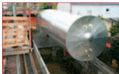
Le 26 avril, la cuve de chauffage du prochain hôtel de ville est arrivée sur le chantier.
