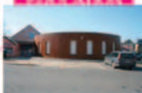
Travaux dans les écoles. École François Delsa : suite des travaux d'extension. École Jean Lantier : remplacement des ouvertures.
