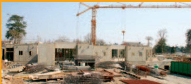
Sur le chantier de l'EHPAD, les travaux se poursuivent.
