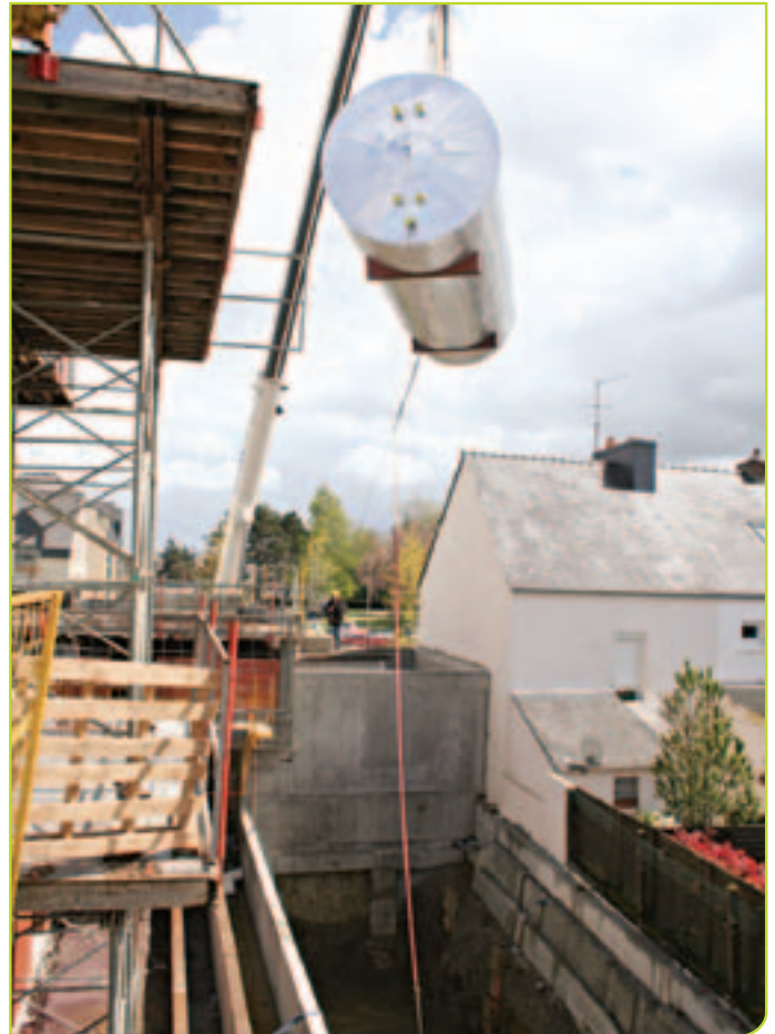
Installation de la cuve pour le système solaire thermique.
