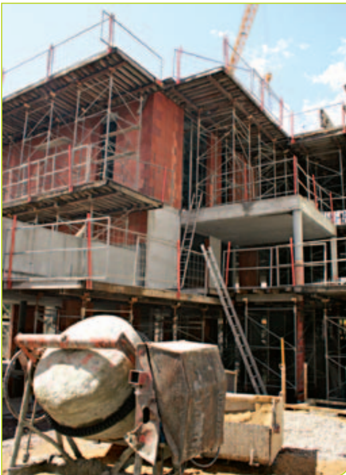
Les travaux de la mairie.
