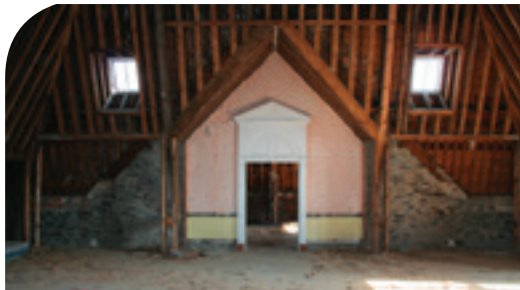
À l'intérieur du bâtiment existant, le chantier est déjà bien entamé.
