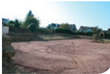
Le terrassement est prêt du côté de la future extension.
