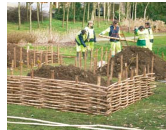
Fabrication à la main des plessis en châtaignier
